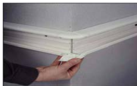
شکل ۴۴- نصب درپوش ترانکینگ زاویه دار
