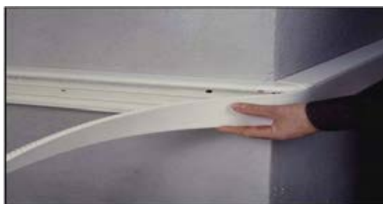
شکل ۴۴- نصب درپوش ترانکینگ زاویه دار
