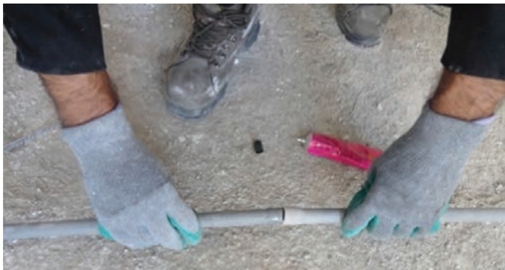
شکل ۴۵- اتصال لوله PVC
