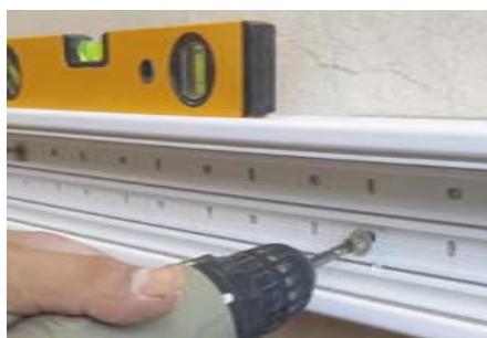
شکل ۴۹- نصب ترانکینگ
