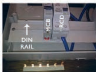
ب) قبل از نصب شین
