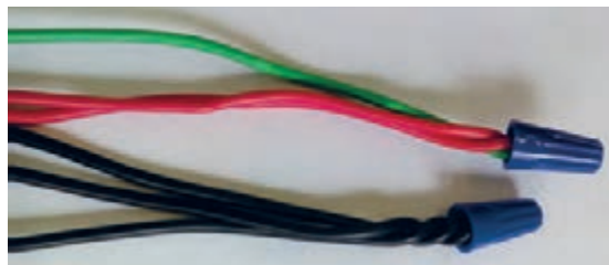
شکل ۴۳- بستن کانکتور پیچی
