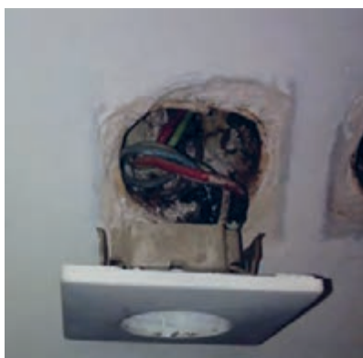
شکل ۳- قاب جداشده پریز از دیوار
