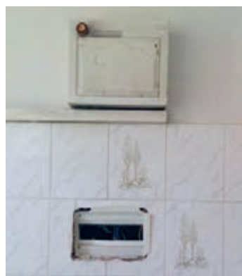
شکل ۲- نصب تابلو فیوز روکار با نوع آسیب دیده توکار
