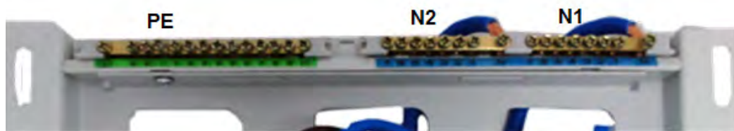
شکل ۸۰- ترمینال‌های نول و اتصال زمین
