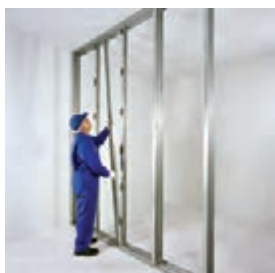
اجرای ردیف دوم استاداها
