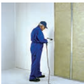
اجرای پانل‌ها در دو طرف دیوار
