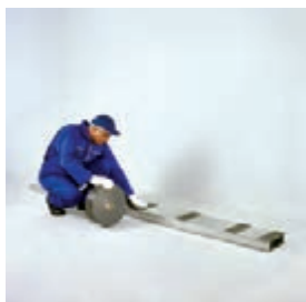
اجرای نوار عایق بر روی استاداها
