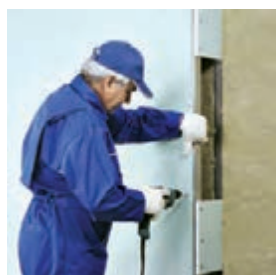
اجرای پانل ها در طرف دیگر دیوار
