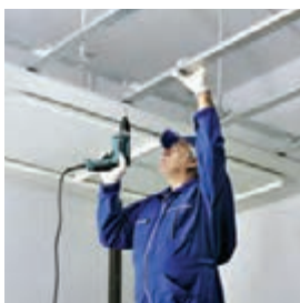
اتصال پانل به زیرسازی توسط ۷ پیچ (هر ۱۷ سانتی‌متر)
