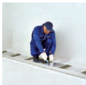
برش نوارهای عایق
