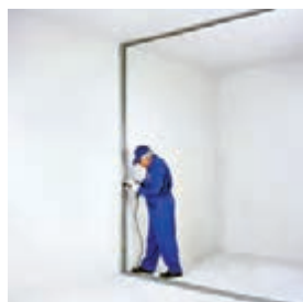
نصب استاد بر روی ساختار جانبی اتصال استاد به دیوار بنایی با رول پلاک (به صورت شاقولی)
