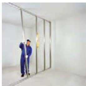
نصب استاد بر روی ساختار جانبی اتصال استاد به دیوار بنایی با رول پلاک (به صورت شاقولی)
