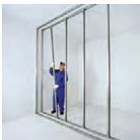
اجرای ردیف اول استاداها
