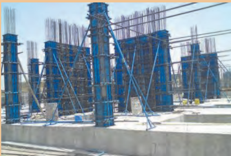
قالب‌بندی و آرماتوربندی ستون
