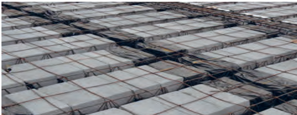
اجرای شناژ مخفی در سقف تیرچه بلوک
