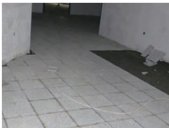
شکل ۲۷-۴ اجرای کف موزائیک در داخل ساختمان
