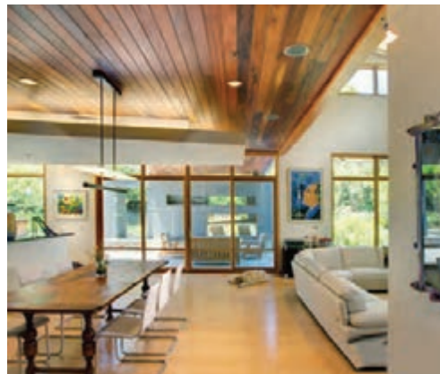
شکل ۲۵-۴- سقف لمبه کوبی شده چوبی
