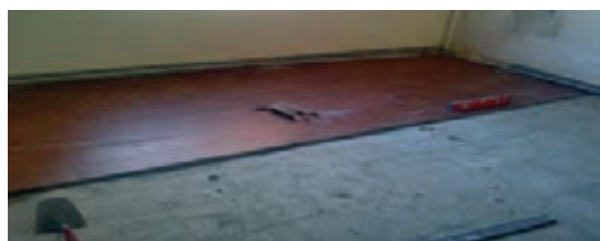
شکل ۲۸-۴ اجرای کف پوش لمینت
