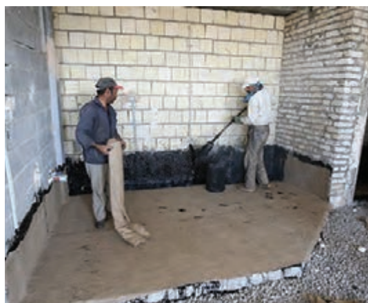
شکل ۴-۱۰- اجرای قیرگونی کف فضای داخلی بر روی دیوار
