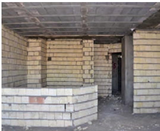
شکل ۴-۴- تیغه چینی داخلی با بلوک سفالی
