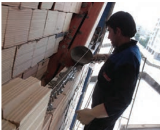
شکل ۴-۶- ملات ماسه سیمان جهت اتصال بلوک‌ها
