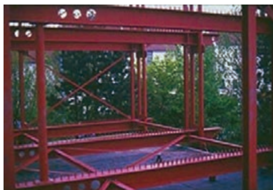
شکل ۲-۹۷- سازه‌ای مرکب از تیر و ستون و بادبند
