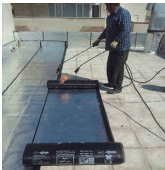
شکل ۴-۱۲- اجرای ایزولاسیون پیش ساخته بر روی کف بام
