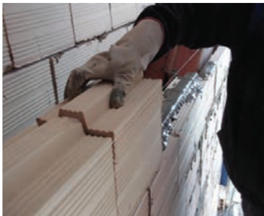
شکل ۴-۵- اجرای بلوک سفالی در امتداد ریسمان
