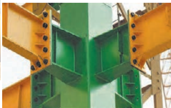
شکل ۵۰ ▲ انواع اتصال فلنجی
