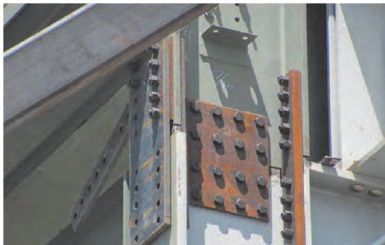
شکل ۵۷ وصله پیچی ستون
