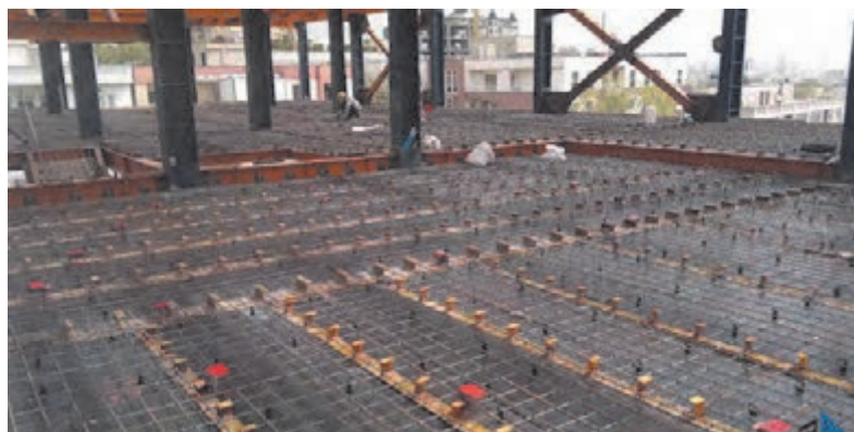
شکل ۳۲ ▲ سقف مرکب به همراه برشگیرها
