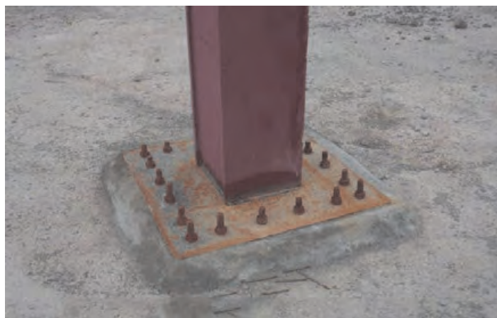
شکل ۴۹ ▲ اتصال مستقیم ستون به کف ستون
