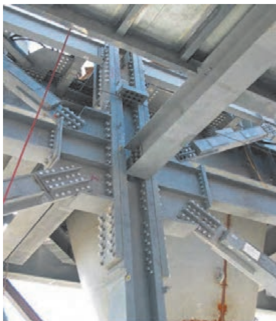
شکل ۵۱ ▲ اتصال مهاربندی
