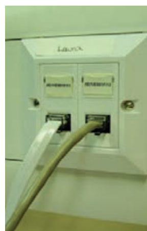
شکل ۲۶-۳- تصویر ظاهری و شمای فنی پریز تلفن
