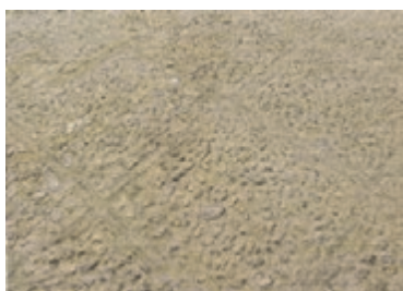
شکل ۲-۱۰۵- یزد، باغ دولت آباد، آژیانه
