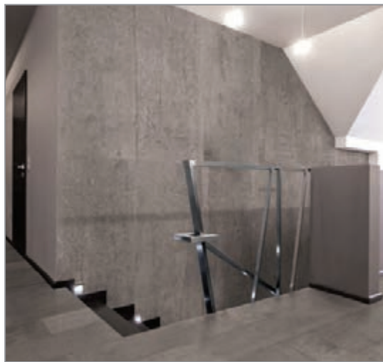
شکل ۴-۱۵ یک جدارة داخلی از بتن نمایان قالبی
