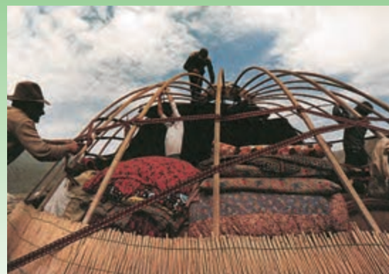
۳-۲-۶ بررسی مصالح، تکنولوژی و سازه‌ی ساختمان:
