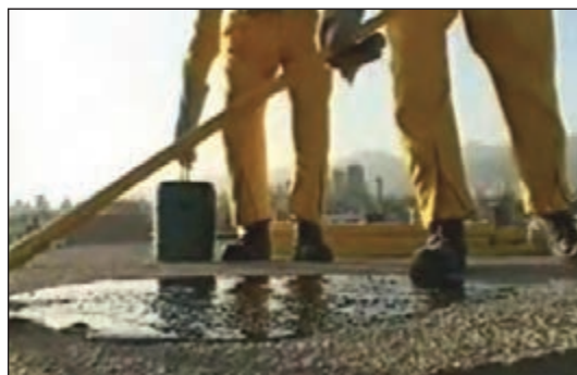
شکل ۲۲-۶ قیرگونی پس از پرکردن بین کُرم‌ها
