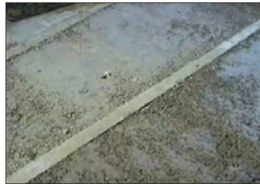
شکل ۲۱-۶ پرکردن فضای بین کرم‌ها با پوکه معدنی
