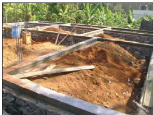
شکل ۲۰۵-۱ بتن ریزی کلاف بندی افقی تحتانی
