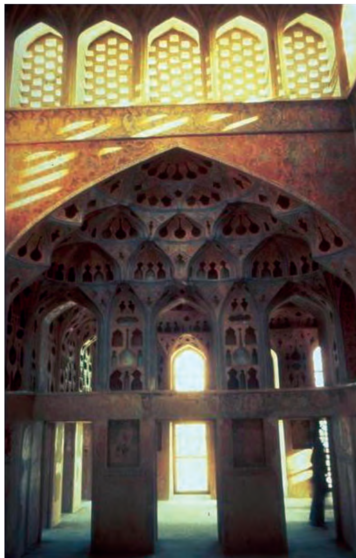
تصویر ۲-۸ - نور از طریق پنجره‌های مشبک آجری و یا گلوبی به داخل تابیده می‌شود
