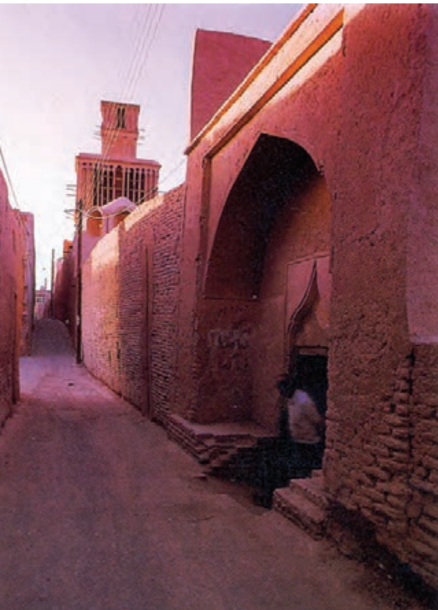
تصویر ۹-۵- نمای بیرونی فاقد پنجره
