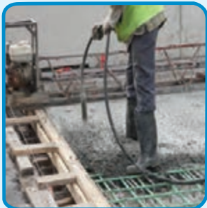
شکل ۱۴-۳- وایبراتور یا لرزاننده بتن داخل قالب
