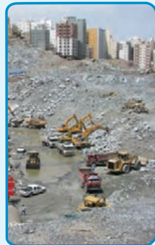
شکل ۳-۷- گودبرداری در زمین‌های نامحدود
