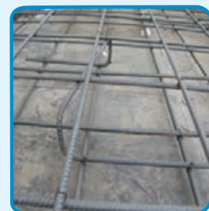
شکل ۳-۵۵- استفاده از خرک در میلگرد گذاری دال
