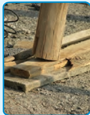
شکل ۳-۲۵- استفاده از گُوه جهت تنظیم ارتفاع
