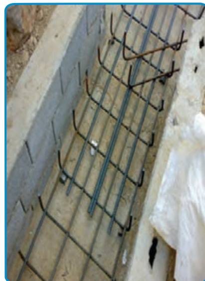
شکل ۷-۱۱- قرار دادن میلگردهای تقویتی
